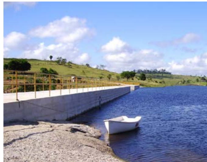
Barragem de Mucurici – Montanha – ES Mucurici Dam
